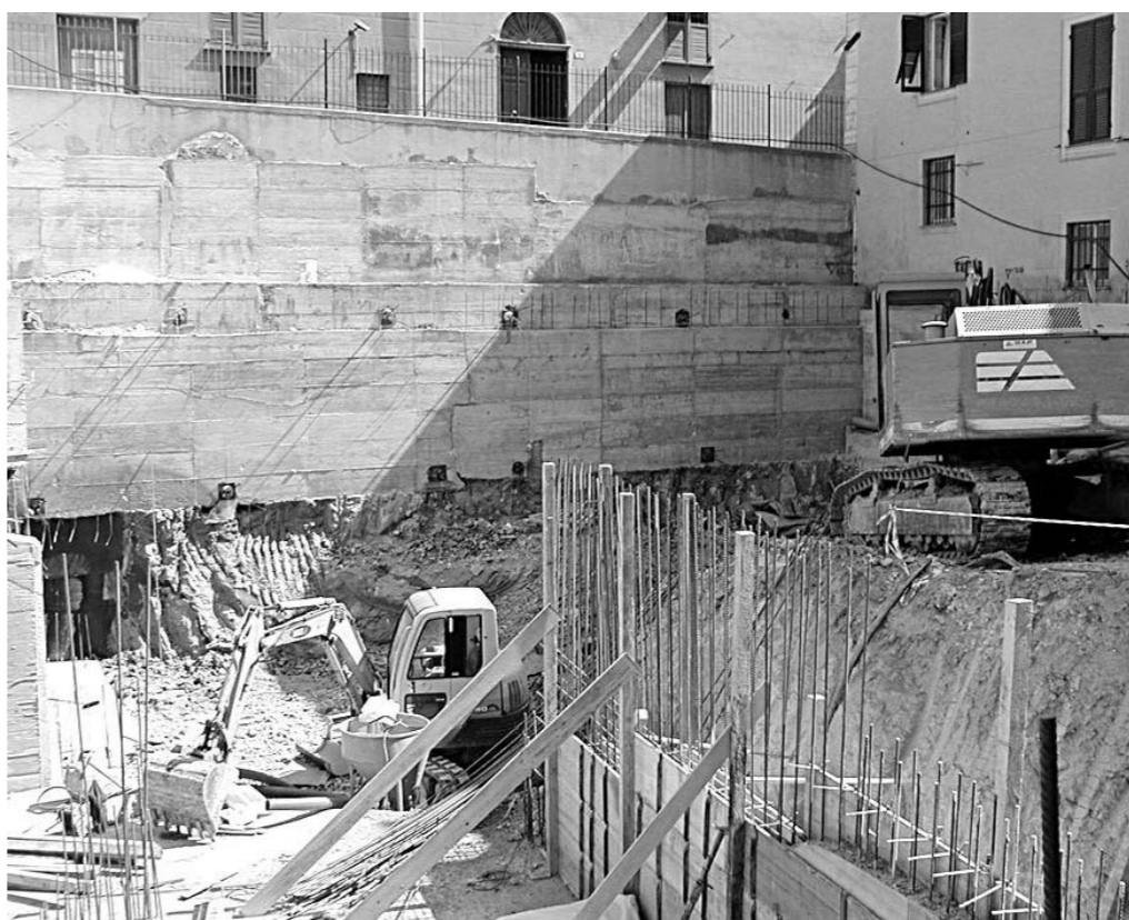
Il cantiere di via Rossello dove sono in corso di realizzazione 21 box ad opera della società Gares
