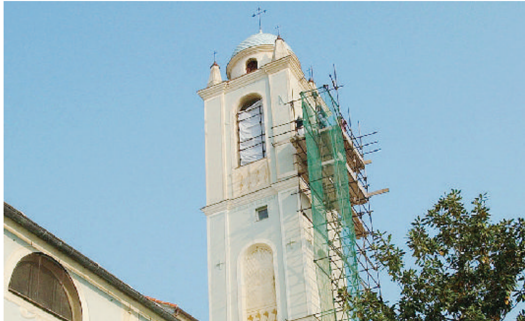
Il campanile, attualmente ingabbiato dalle impalcature, della chiesa della Concordia ad Albissola Marina
